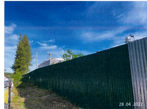
ภาพที่ 2-10 กำแพงกันเสียงบริเวณพื้นที่ก่อสร้าง
