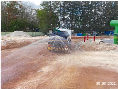
ภาพที่ 2-1 การฉีดพรมน้ำบริเวณพื้นที่ก่อสร้าง
