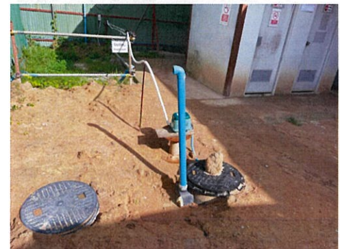
ภาพที่ 2-12 ระบบบำบัดน้ำเสียสำเร็จรูป (Septic Tank)
